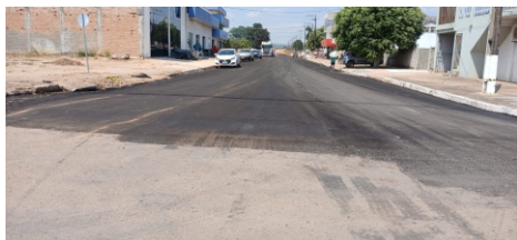
Av. Jonas Pinheiro, frente Loja Dom Bosco já recebeu o revestimento.
