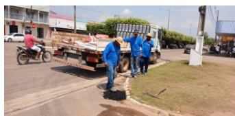
Prefeitura de Apiacás fazendo correções no asfalto, antes de colocar o revestimento.
