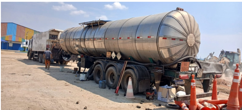
Empresa Benetti Asfaltos Ltda, próximo do ginásio de esporte com o caminhão/tanque com produtos para o revestimento
