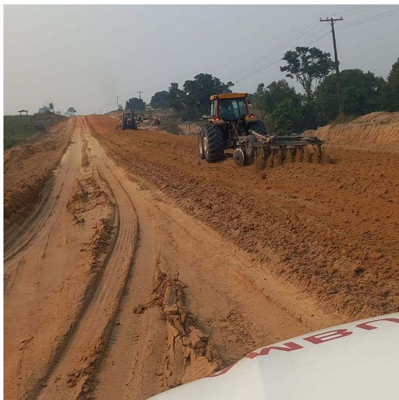
Terraplanagem já pertinho de Apicás. Foto: Gustavo Caetano dia 25/09/24
